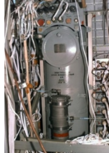
図 1-3-6-ISS 宇宙船内の電気分解による酸素発生装置“Elektron”、ロシア製
