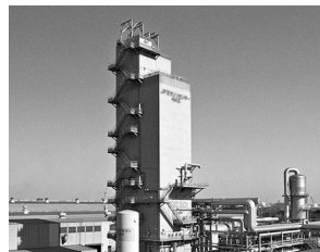
図 4-6-1-コールドボックス (深冷空気分離装置)
