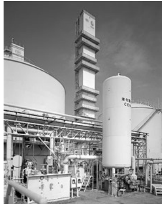
図 5-2-酸素同位体 ^{18}\text{O} 製造プラント
