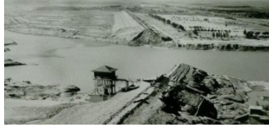
図6-10-12-中国板橋ダム決壊事故(1975年)
