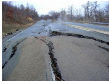
図 6-9-2-セントラリアの坑内火災によって使えなくなった米国ペンシルベニア州の州道、出典 Wikipedia
