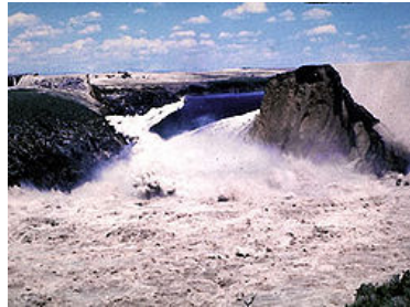
図6-10-13-米国ティートンダム決壊事故(1976年)
