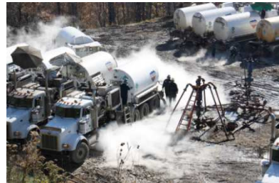
図 6-5-6-シェールガスの採掘のための液体窒素タンクローリー
