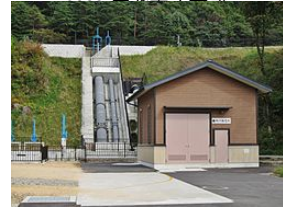
図 6-7-3-4.町川発電所(長野県、 140kW)
