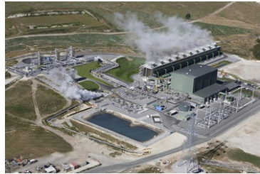
図 6-7-6-5 ニュージーランドのナ・アワ・ブルア地熱発電所
