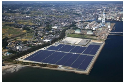
図6-7-4-1-中部電力メガソーラー「たけとよ」と武豊火力発電所
